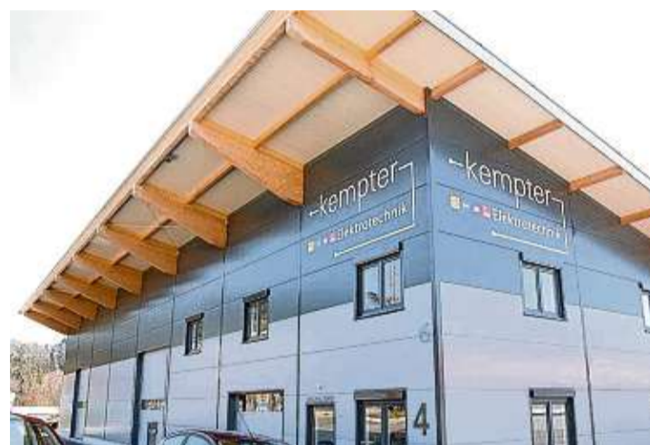
Vor einem halben Jahr konnte der Neubau im Gewerbegebiet Himmelreich bezogen werden.
